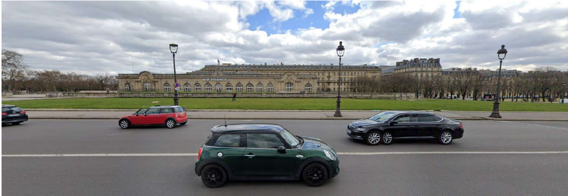
7—Vue prise de l'avenue du Maréchal Gallieni sur le bâtiment Aérogare (mars2021)
