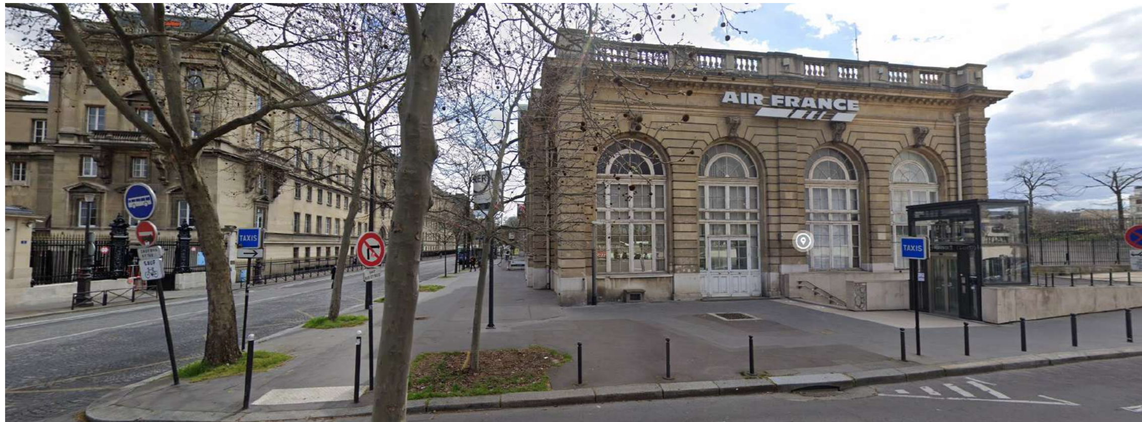
5—Vue prise à l'intersection du Quai d'Orsay et rue Robert Esnault-Pelterie sur le bâtiment Aérogare et ministère des Affaires Etrangères (mars 2021)
