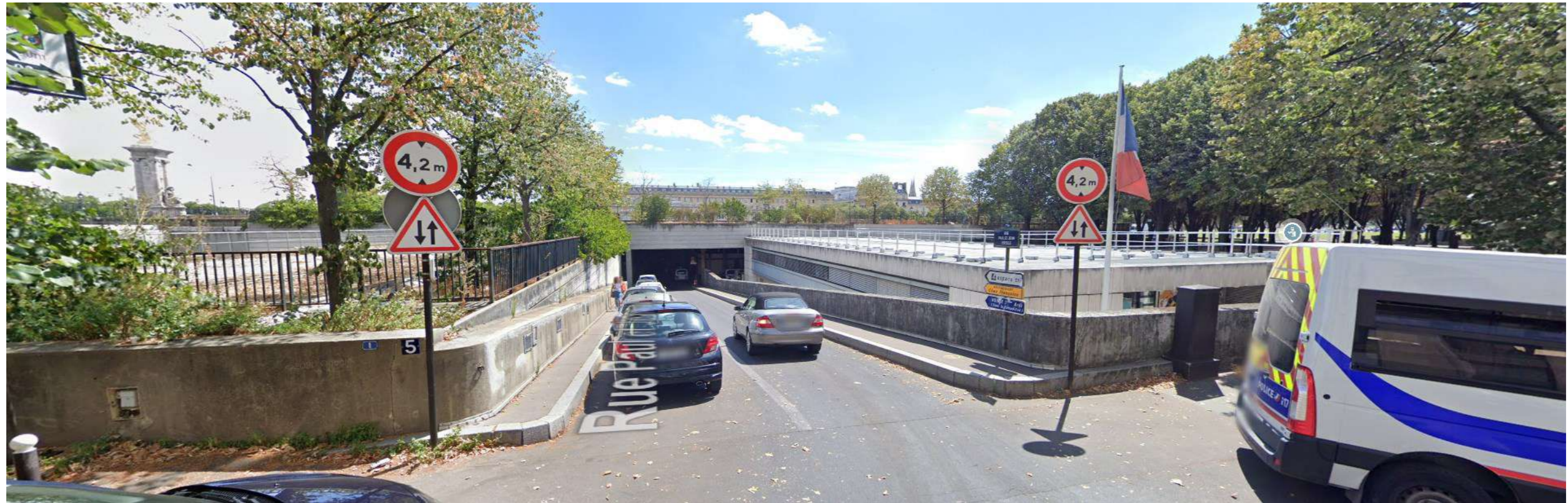
3—Vue prise à l’intersection de la rue Fabert et rue Paul et Jean Lerolle sur la rampe nord (juillet 2020)
