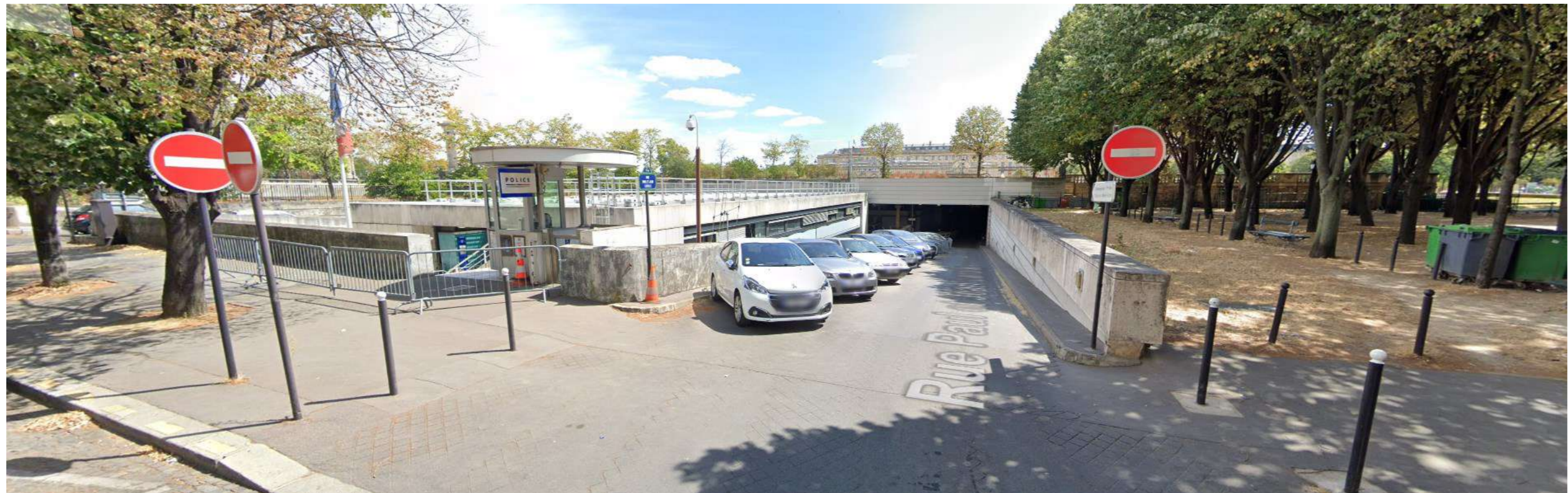
4—Vue prise à l’intersection de la rue Fabert et rue Paul et Jean Lerolle sur la rampe sud (juillet 2020)
