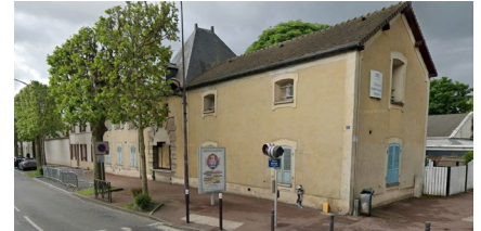
Bâtiment ancien situé avenue Mazarin qui est réhabilité dans le projet
