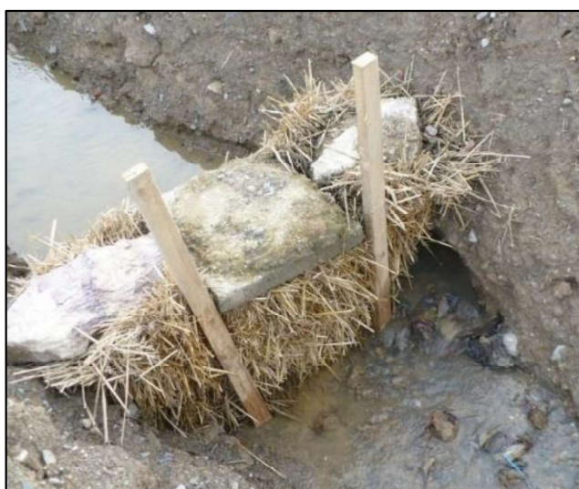
Photo : Emplacement de bottes de paille en phase travaux, dans un bassin d'orage et un cours d'eau
