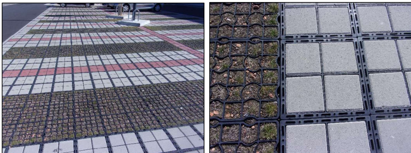
Photo : Exemple de parkings en pavés drainants – Magasin LIDL de Noyal-Châtillon-sur-Seiche
