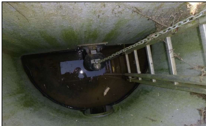
Figure 9 : Exemple d'une vanne à chaînette dans un ouvrage de sortie de bassin d'orage
