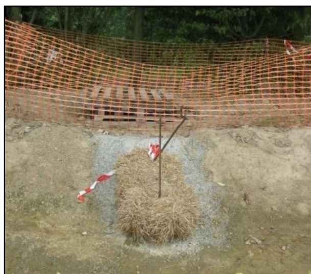
Photo : Emplacement de bottes de paille en phase travaux, dans un bassin d'orage et un cours d'eau
