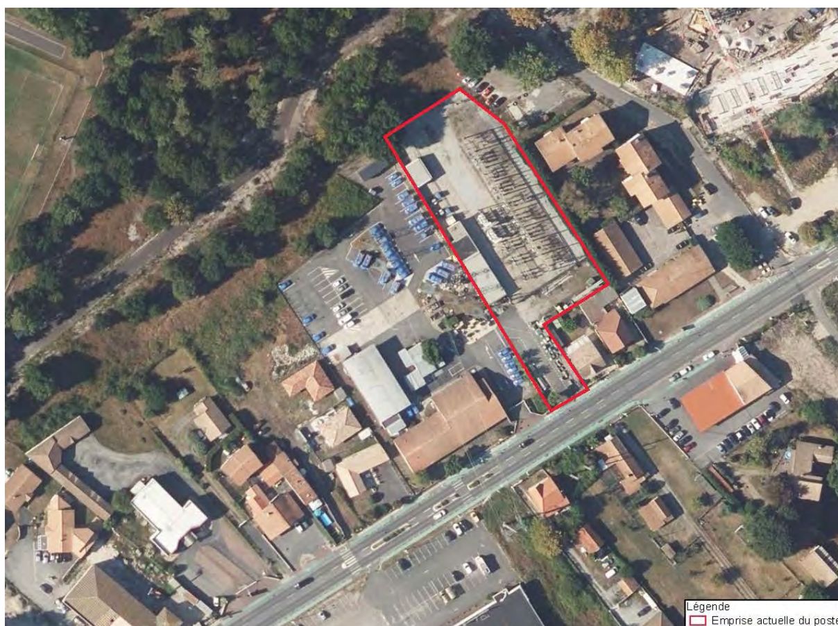
Figure 1 : Vue aérienne sur le poste électrique existant
