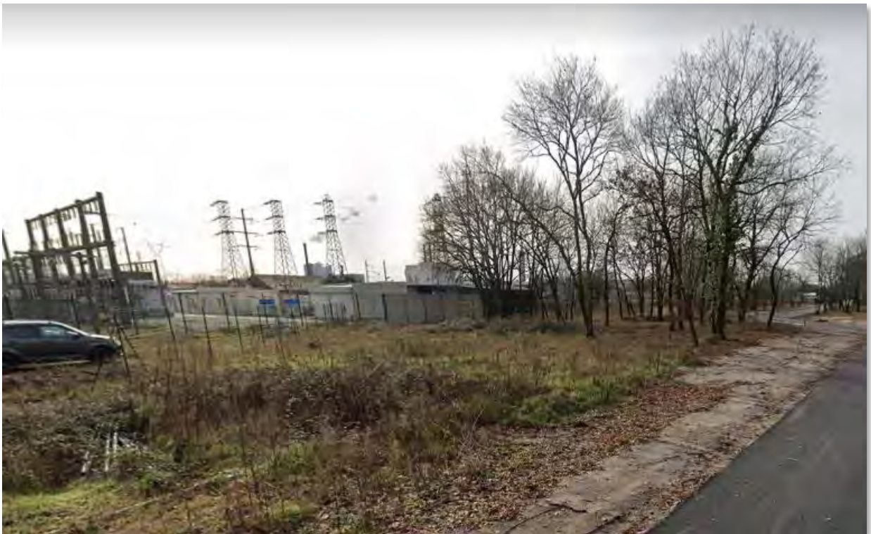
Point de vue n° 2 – Vers le poste existant et la parcelle d'extension
