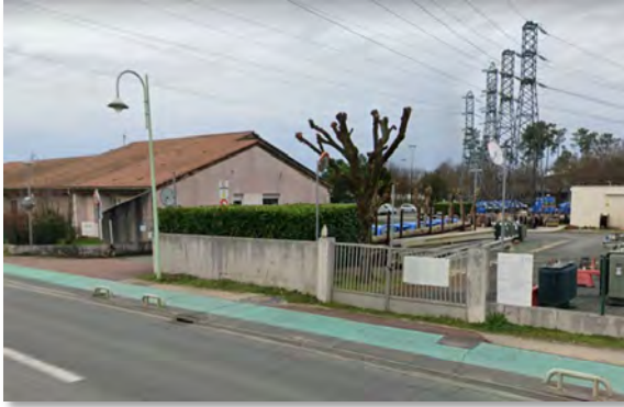
Route départementale RD650 et piste cyclable longeant l'emprise du poste existant (source : Google Earth)
