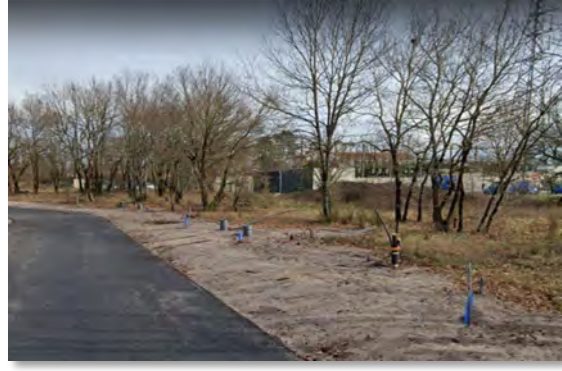
Rue de la Gendarmerie longeant le nord de l'emprise d'extension (source : Google Earth)
