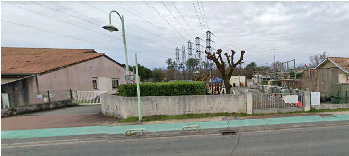
Vue sur le poste source de Facture depuis le sud (route départementale RD650) - source : Google Earth
