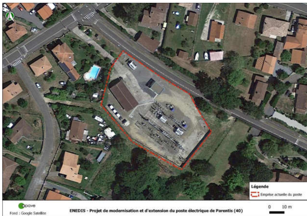
Figure 1 : Vue aérienne sur le poste électrique existant
