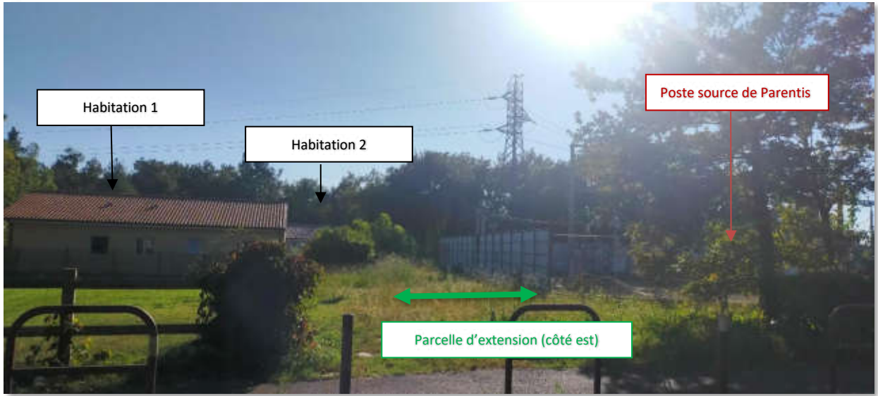
3 – vue depuis l'avenue de la voie ferrée sur le poste existant, la parcelle d'extension (côté est) et l'habitation 1 et 2
