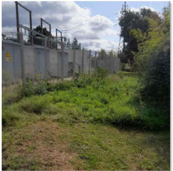
11 - Vue sur le poste depuis le sud-ouest
