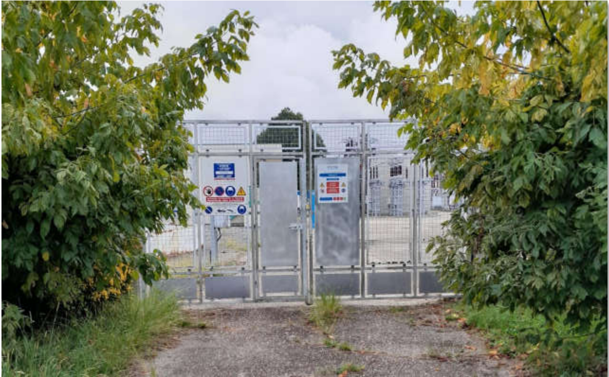
1 – vue sur l'entrée du poste de Parentis
