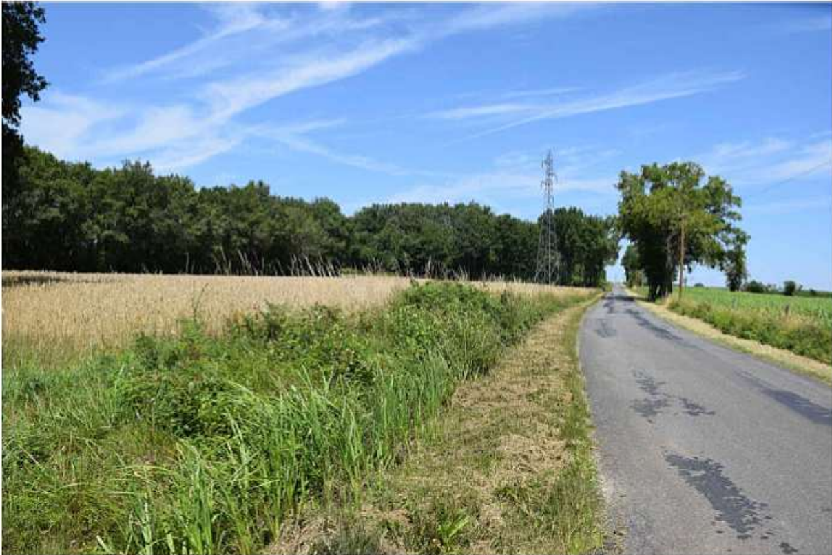
Vue 1 - état existant
