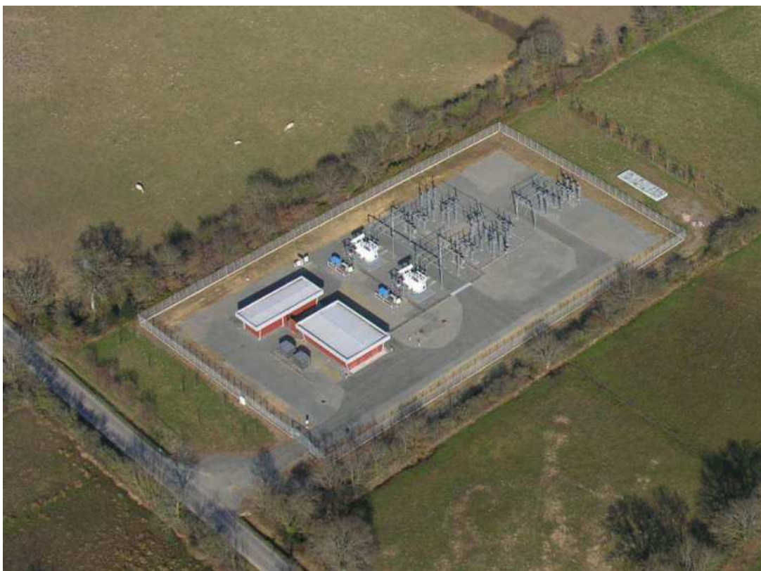
Illustration 5 : Exemple de poste de transformation
