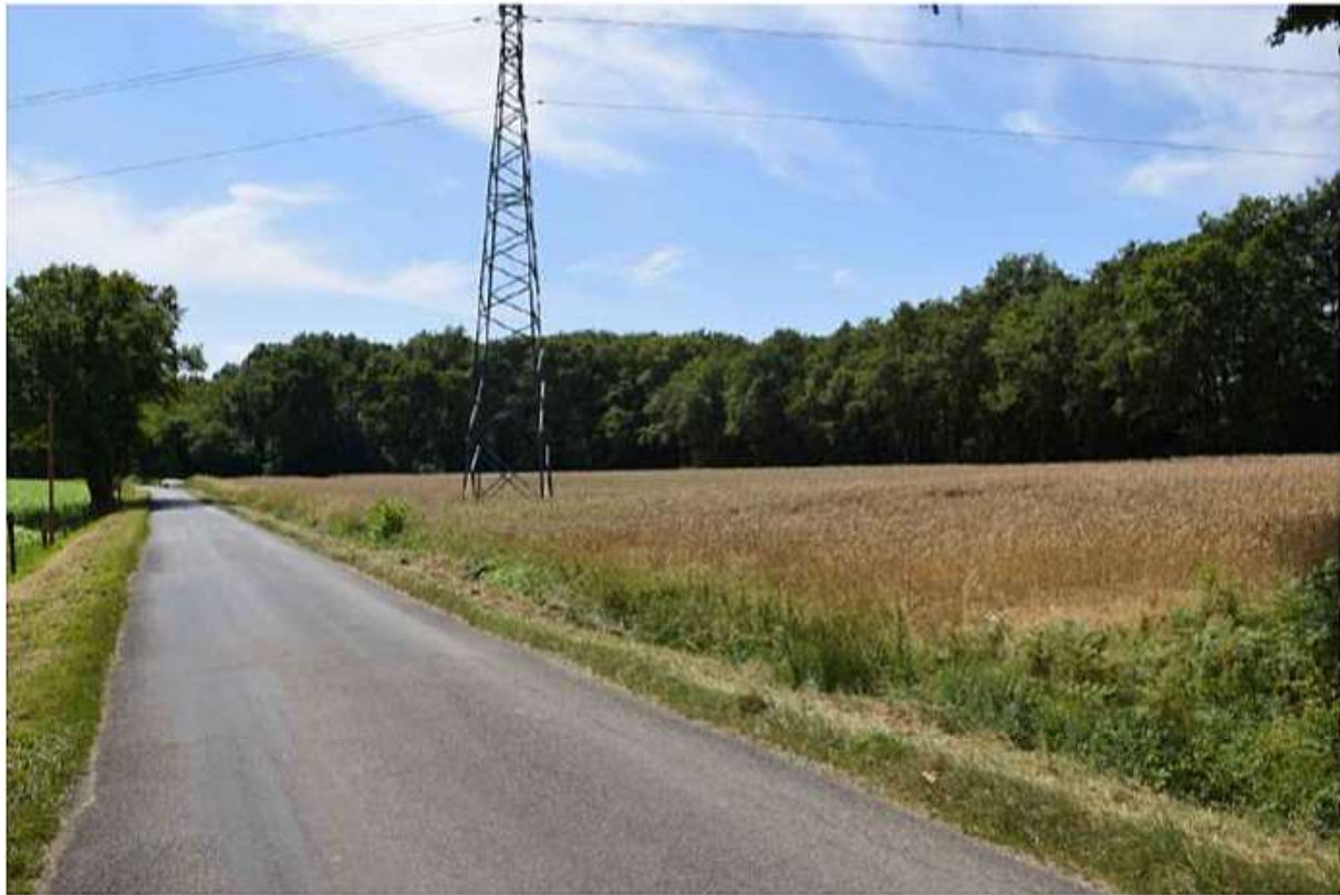
Vue 1 - état existant
