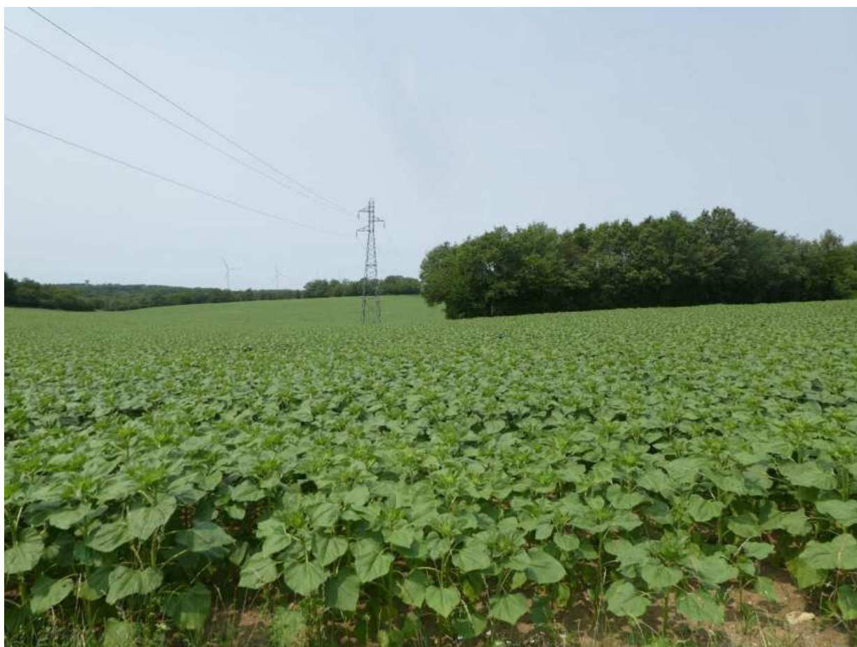
Illustration 31 : La ligne électrique à 90 kV LONGCHAMP-CONFOLENS au niveau de la RD343 dans l'aire d'étude (Source : EGIS, Juin 2023)
