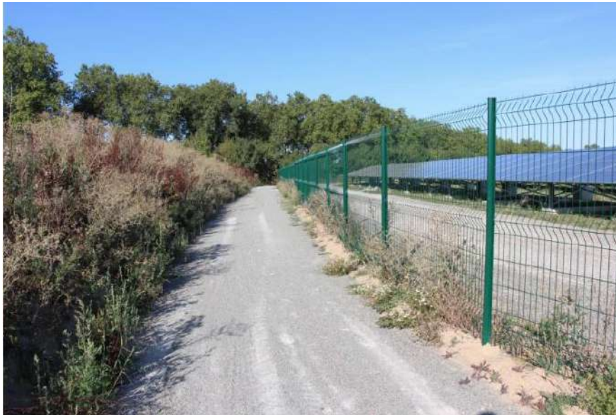
Exemple de clôture d'enceinte d'une centrale photovoltaïque
